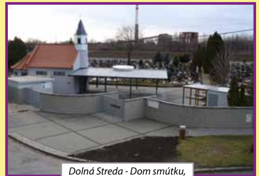
Dolná Streda - Dom smútku, obradné a vstupné priestory
