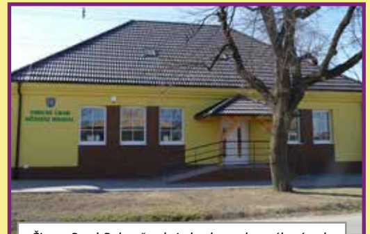
Čierny Brod-Rekonštrukcia budovy obecného úradu
