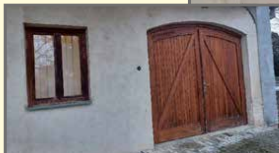
Modernizácia garážovej brány obecného úradu
