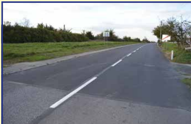
Maters Nový asfaltový koberec na štátnej ceste smerom na železničnú stanicu...
