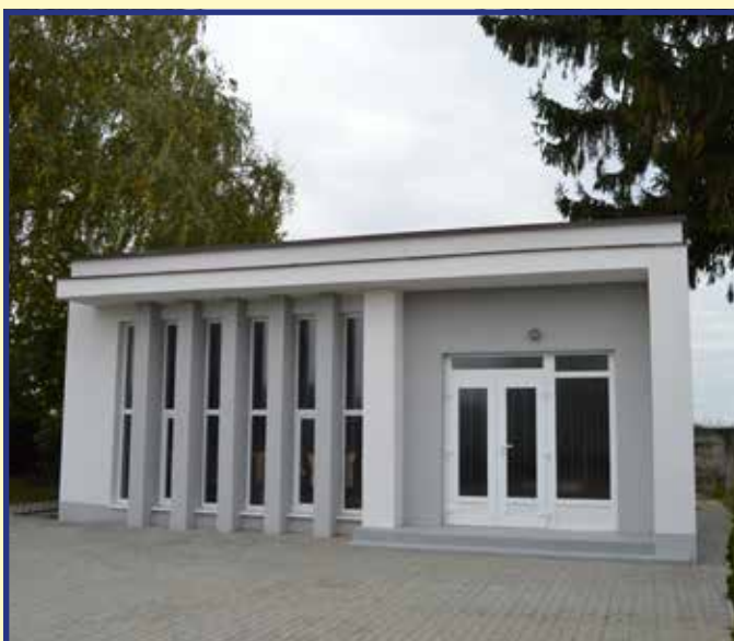
Zrekonštruovaný dom smútku v Ondrochove
