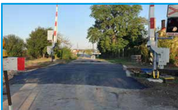
Rekonštrukcia železničného priestestia
